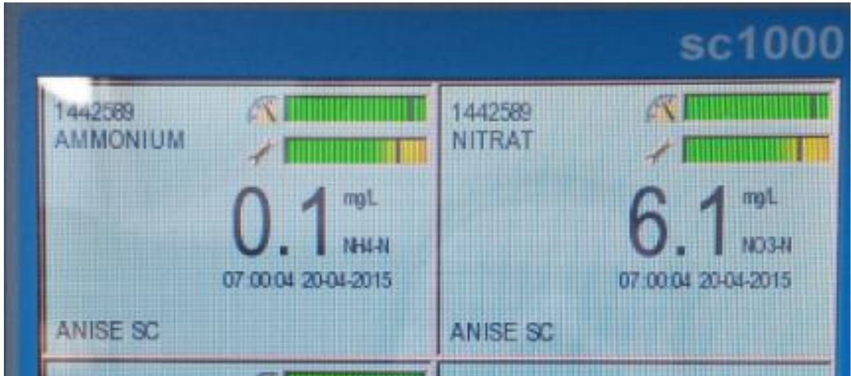
Bild: Intelligenter Messumformer (Fa. Hach) für Ammonium (NH 4 -N) und Nitrat (NO 3 -N) mit integrierter Evaluierung des Messsignals (oberer Ampelbalken: Zuverlässigkeit des Messsignals, unterer Ampelbalken: Gerätezustand und Hinweise auf erforderliche Wartungsarbeiten) (Bildquelle: Wiese)
